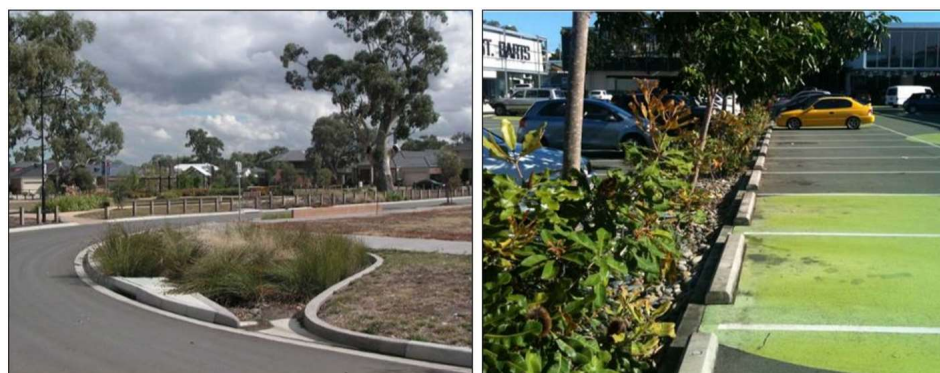
Figur 6.4. Öppning i kantsten, inlopp till växtbädd (Waterbydesign, 2014)
